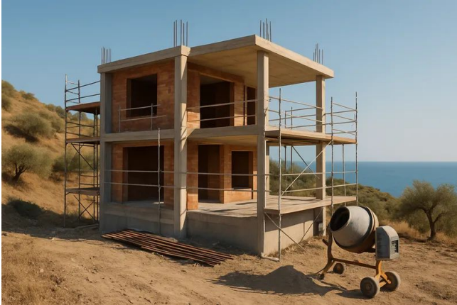
Råbygget i september: betongskjelett og murvegger, stillaset står fortsatt.
