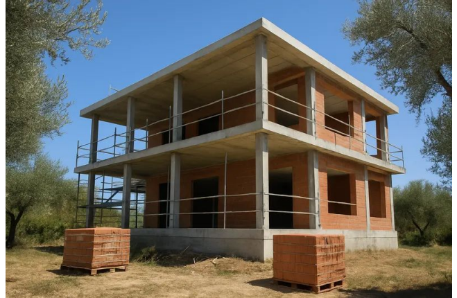
Råbygget sett fra nedsiden av tomta. Begge dekkene er støpt.
