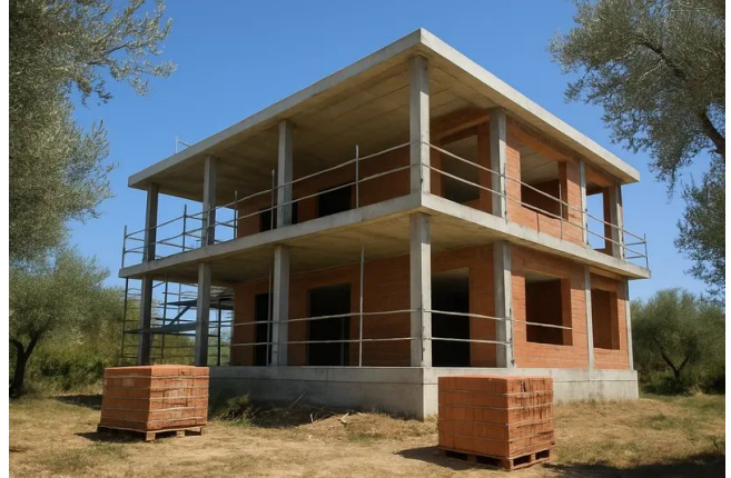
La estructura bruta vista desde la parte inferior del terreno. Ambas losas están coladas.
